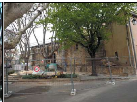
Vue depuis le Sud : restauration de l'église
