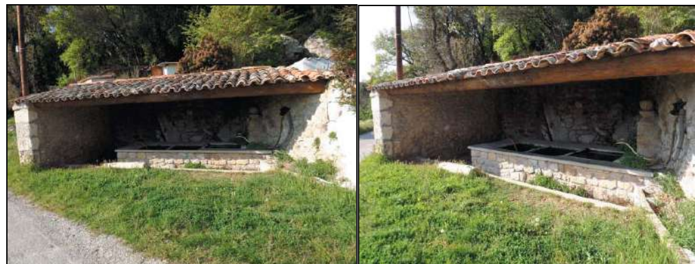
Vue sur le lavoir depuis le chemin
