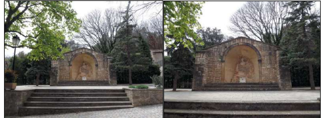
Vue depuis l'avenue Gaston Cabrier
