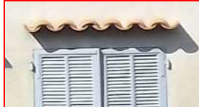
Rangs de tuiles au dessus des linteaux pros crits.
