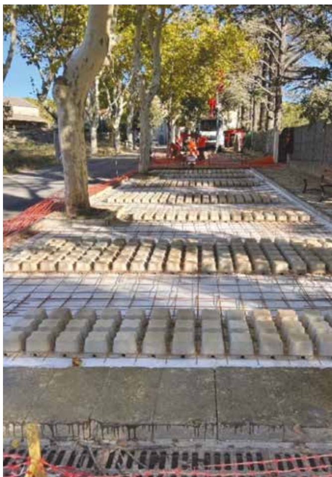
Sur la photo de gauche, on distingue les alvéoles qui seront remplacées après coffrage par du granulat (photo de droite).
